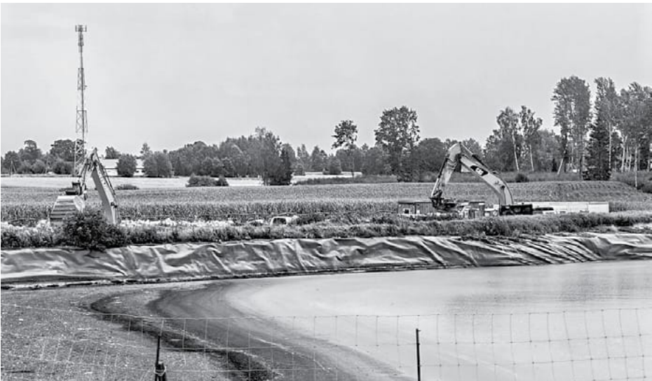
Celtniecība ir sākusies. 9. septembra pēcpusdienas foto redzamas pagaidu mājiņas un zemes darbi. Priekšplānā – iepriekšējās biogāzes stacijas atvērta lagūna
