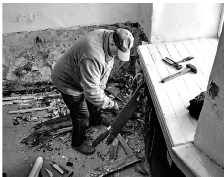
PAGRABSTĀVA bojāto paneļu demontāža.
