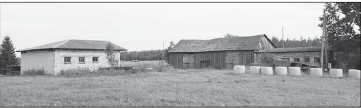
Ērgļu pansionāta kādreizējā palīgsaimniecība, 2026. gads.
